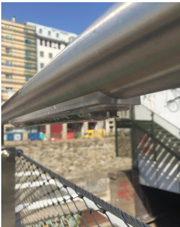
Abbildung 8: Beleuchtung entlang der Absturzsicherung an der Brücke
