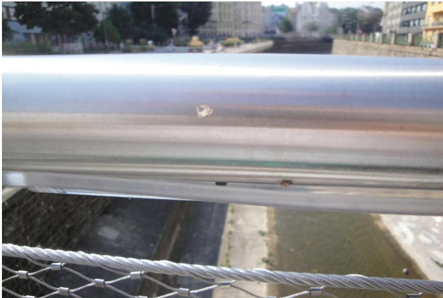
Abbildung 9: Mangelhafte Abdeckung der indirekten Beleuchtung
