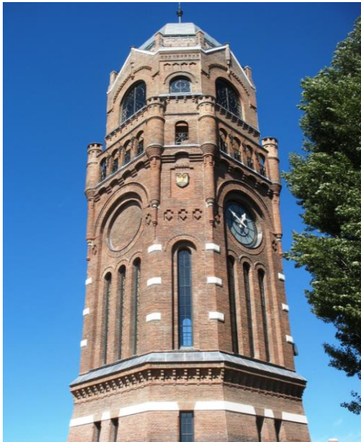
Abbildung 2: Wasserturm nach der denkmalpflegerischen Instandsetzung
