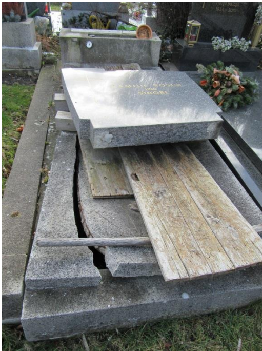
Abbildung 2: Zwischenlagerung eines Grabsteines auf einer längsseitig gebrochenen Grababdeckung
