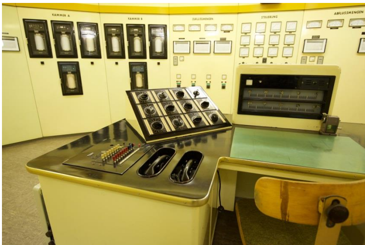
Abbildung 4: Ehemalige Steuerwarte bis 1994 in Betrieb
