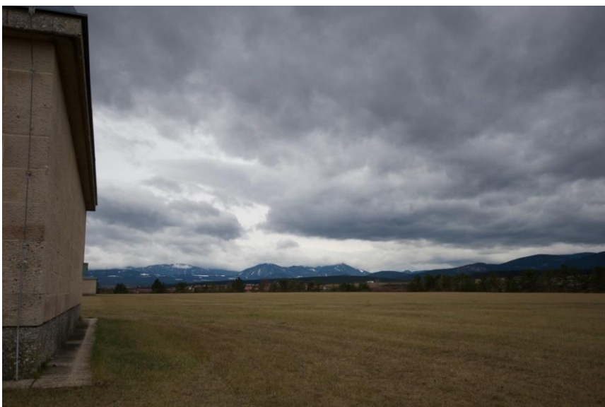
Abbildung 3: Rückseite zweier Einstiegsbauwerke mit begrünter Wasserbehälterdecke
