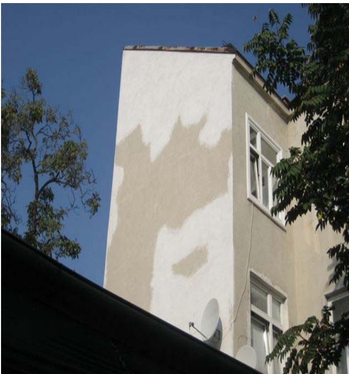
Abb. 3: Feuermauerinstandsetzung
