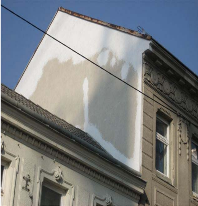
Abb. 2: Feuermauerinstandsetzung
