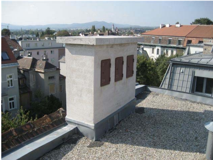
Abb. 6: Rauchfangkopferneuerung
