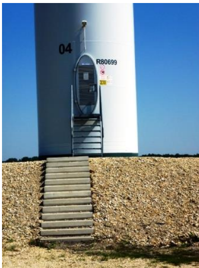
Abb. 7 - Aufgang und Anschüttung
