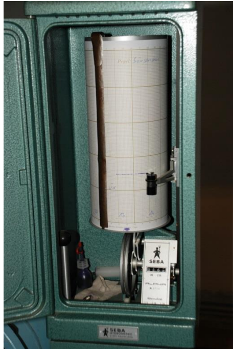
Bildbeschreibung: Messstand Pegel Säusenstein im Pumpwerkwerk Säusenstein/Foto: Stadtrechnungshof Wien
