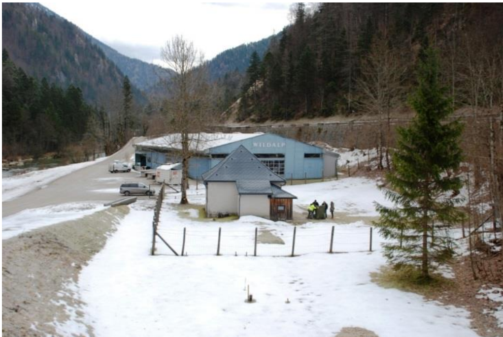
Bildbeschreibung: Im Vordergrund das Pumpwerk Säusenstein/Foto: Stadtrechnungshof Wien
