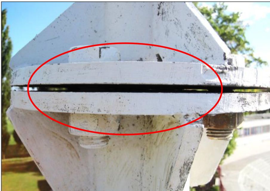
Abb. 2: Zwischenraum zwischen den Flanschen zweier Schüsse
