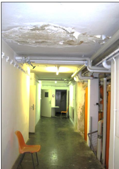
Abb. 3: Pressegebäude Erdgeschoß Gang
