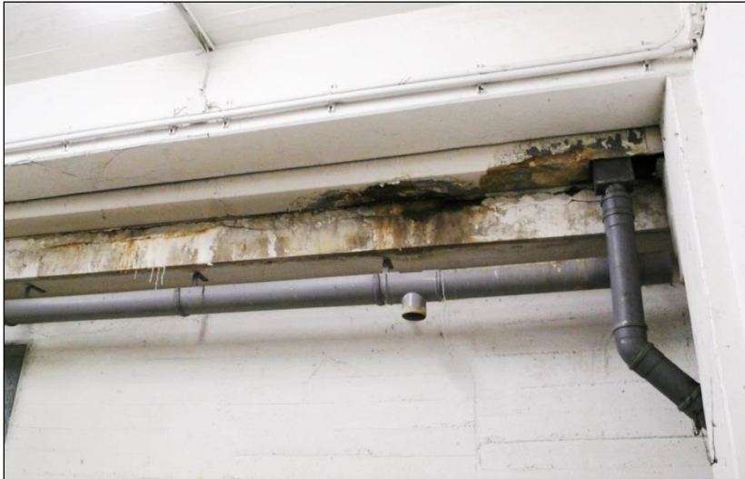
Abb. 4: Pressegebäude Chemikalienlagerraum Untergeschoß
