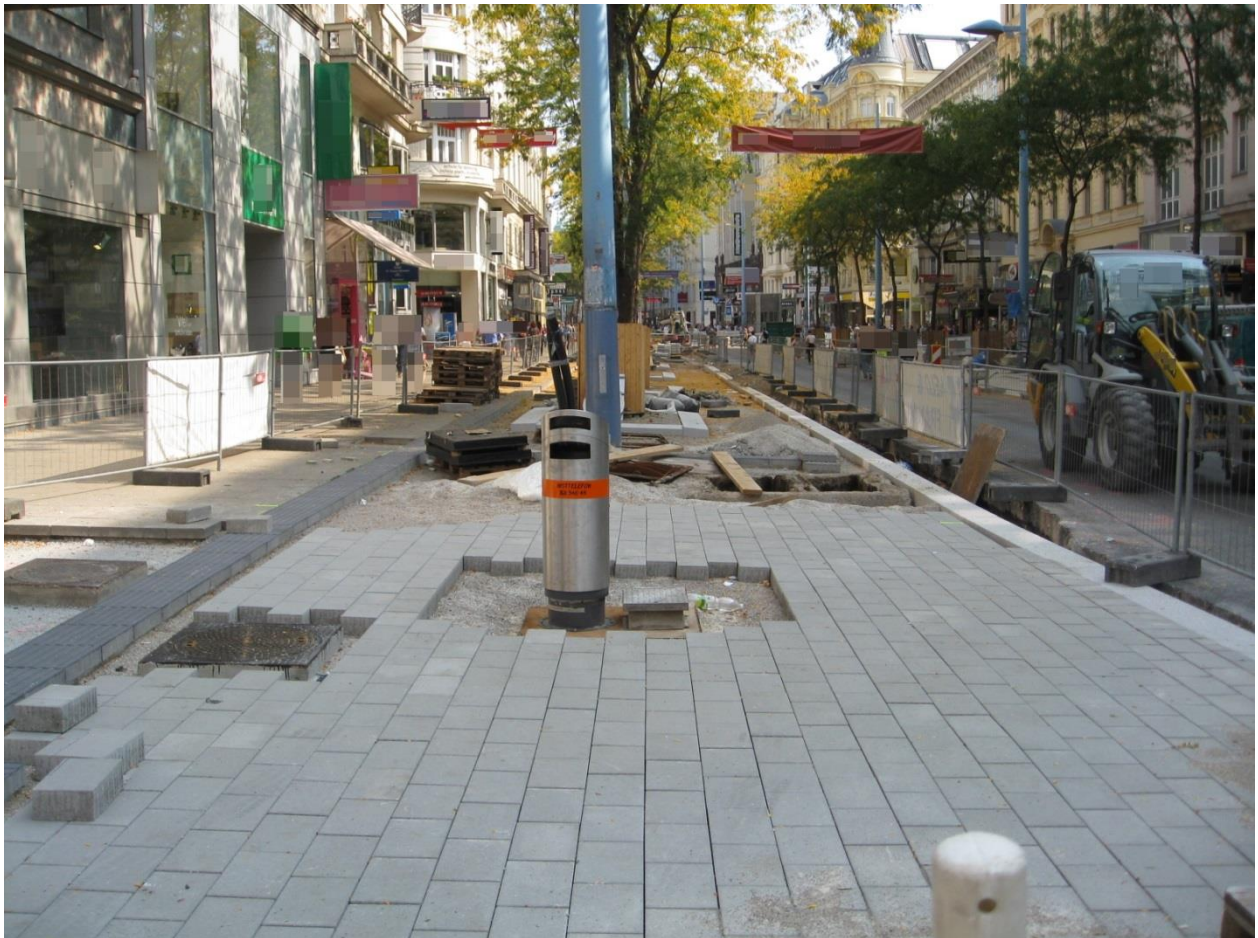
Abbildung 2: Mariahilfer Straße, Umgestaltungsarbeiten
