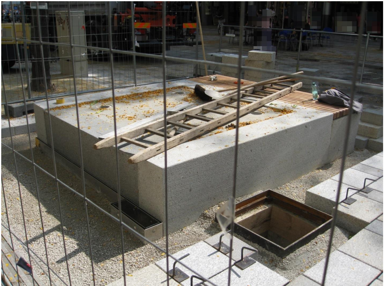
Abbildung 3: Wassertisch (im Bauzustand) als Teil einer neuen Möblierung
