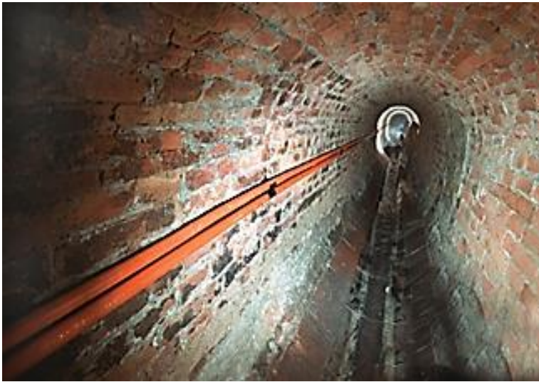
Abbildung 6: Verlegemethode Flexible A, ohne Abdeckung
