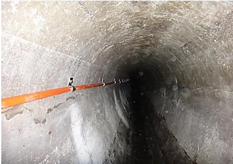
Abbildung 5: Einzelkabelverlegung
