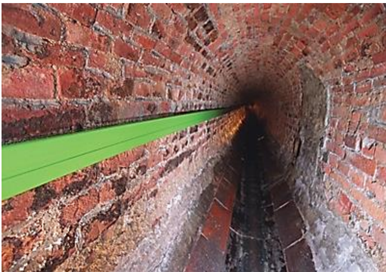
Abbildung 7: Verlegemethode Flexible A, mit Abdeckung
