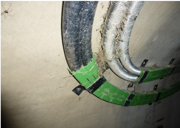
Abbildung 10: Verschmutzungen an der Lichtwellenleitertrasse
