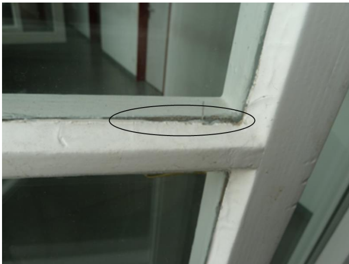
Abbildung 1: Fugen zwischen Glas und Kittfuge
