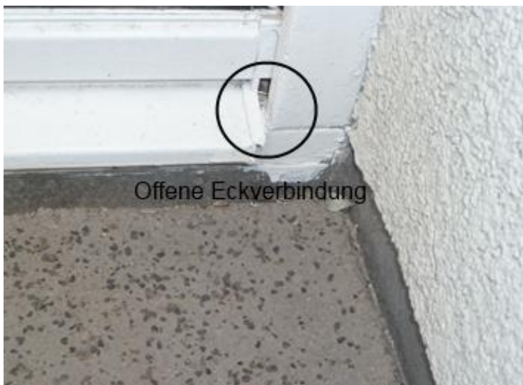
Abbildung 6: Offene Eckverbindung
