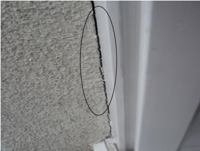
Abbildung 2: Offene Maueranschlüsse
