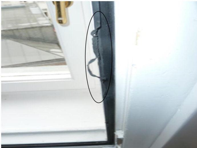
Abbildung 4: Schadhafte Dichtung
