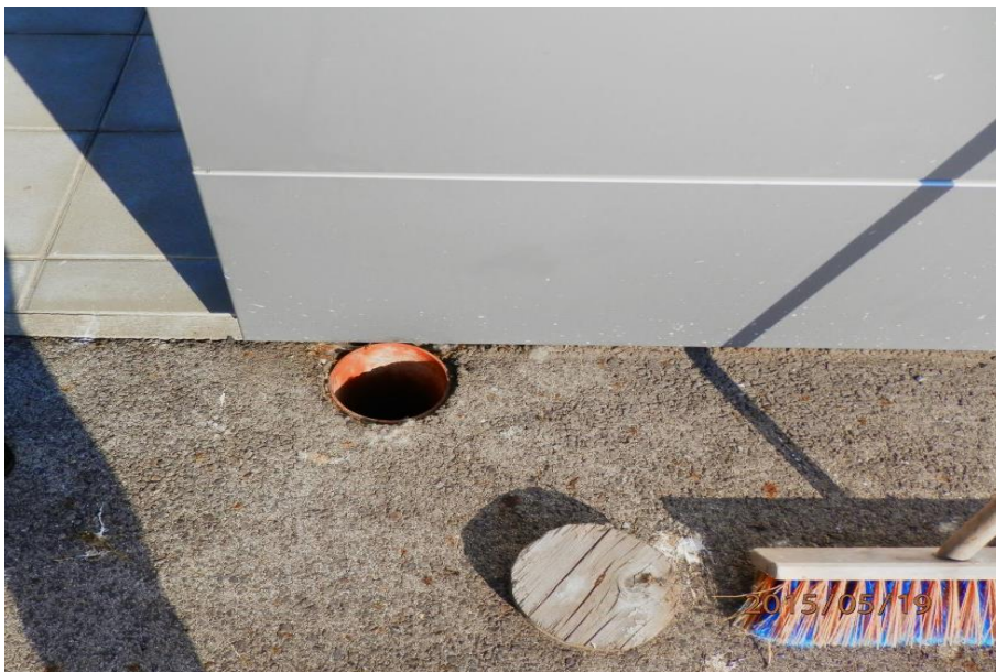
Abbildung 6: Öffnung mit Holzabdeckung im Asphalt
