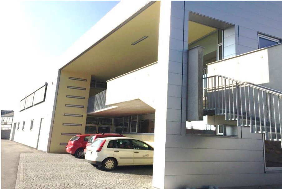
Abbildung 1: Außenansicht des Stützpunktes
