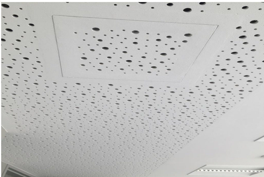
Abbildung 3: Deckenuntersicht mit nachträglich eingebauten Revisionsöffnungen
