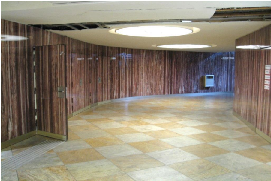
Abbildung 1: Deckenöffnung im Bereich der Stiege 1
