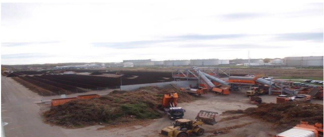
Abbildung 1: Bioabfallaufbereitungsanlage mit Manipulations- und Rotteflächen im Kompostwerk Lobau
