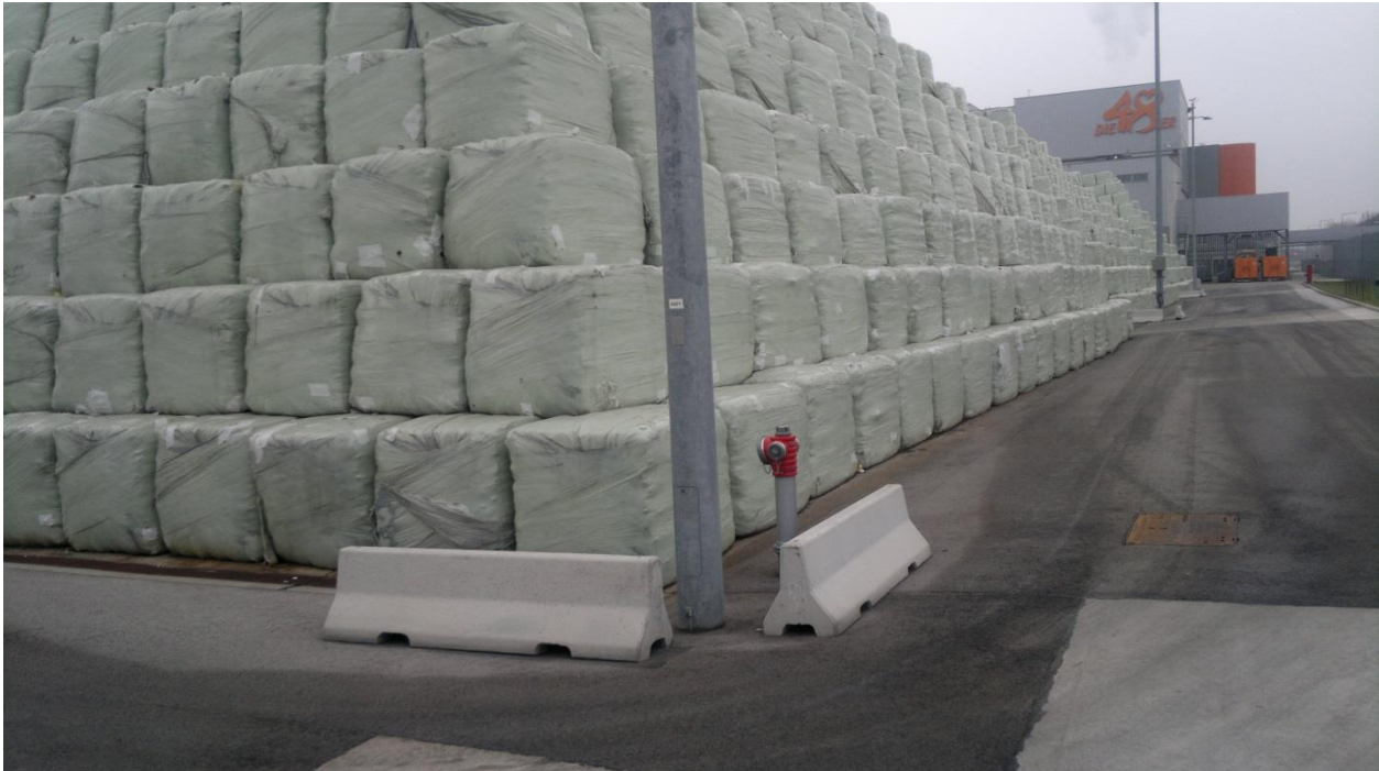
Abbildung 2: Hydrant bei südwestlichem Ballenkegel
