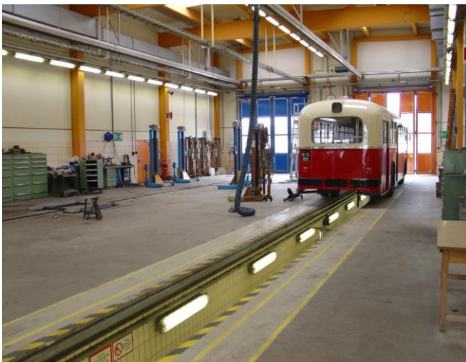
Abbildung 2: Innenansicht der mittleren Prüfstraßen der Kraftfahrzeugprüfstelle
