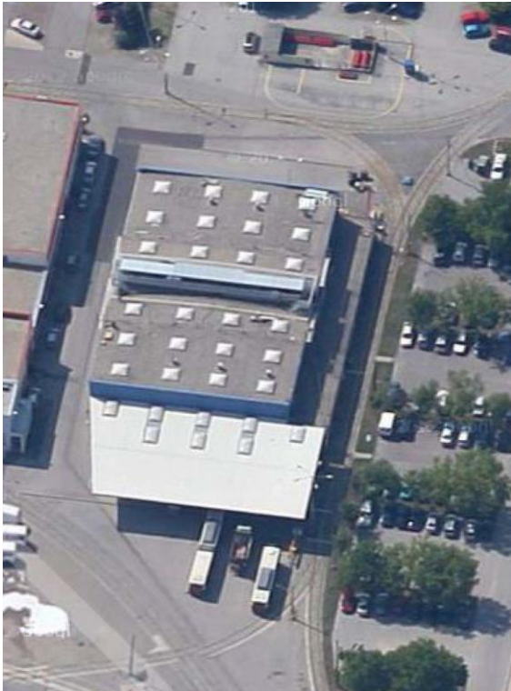
Abbildung 1: Luftbild der Halle der Kraftfahrzeugprüfstelle mit Vordach
