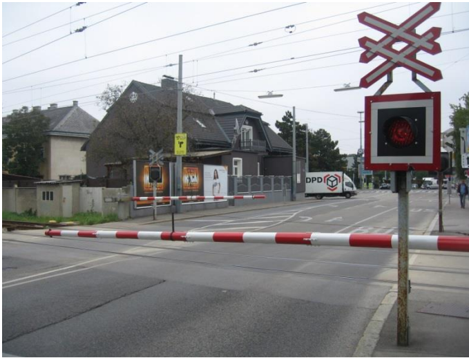
Abbildung 5: Eisenbahnkreuzung Wien 23, Purkytgasse (Bahn-km: 5,454), mit Sicherung durch Lichtzeichen mit Schranken
