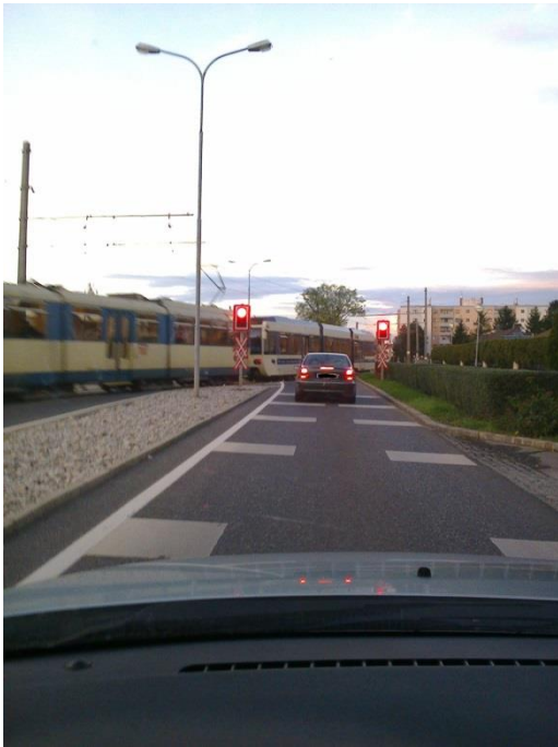
Abbildung 3: Eisenbahnkreuzung Traiskirchen, Hauptstraße B 17 (Bahn-km: 20,090), mit Sicherung durch Lichtzeichen
