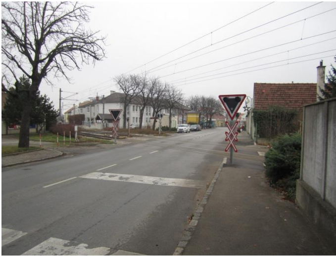
Abbildung 4: Eisenbahnkreuzung Traiskirchen, Pfaffstättner Straße (Bahn-km: 21,521), mit Sicherung durch Lichtzeichen
