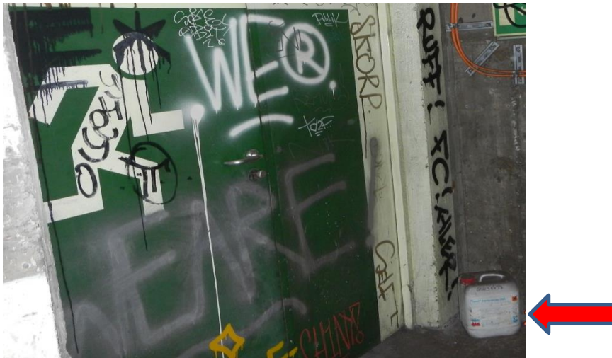
Abbildung 2: Lagerung einer brennbaren Flüssigkeit unmittelbar vor einem Notausgang
